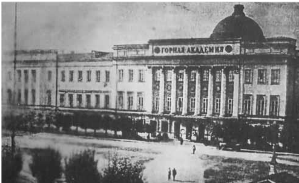
Здание Московской горной академии. В её левом, южном крыле размещался МНИ. Фотография 1920-х гг.
