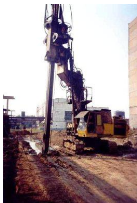
Рис. 2. Строительство противофильтрационной завесы по типу «стена в грунте» вокруг корпуса 31. Павлодарской химической завод, 2002 г.
