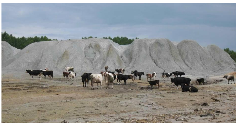
Рис. 2. Общий вид хвостохранилища Урского золоторудного месторождения.
