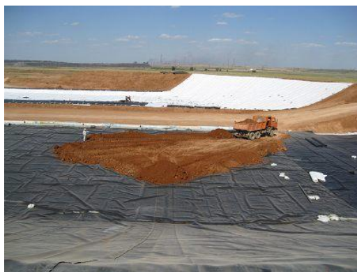
Рис. 3. Укладка многослойного защитного покрытия на полигоне Апан в г. Темиртау, Казахстан, 2008 г.
